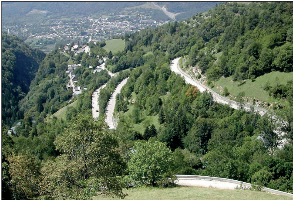
Blick auf die Straßenkehren in einer Höhe von 920 m ü. NN nach einer Strecke von 2 Kilometern
